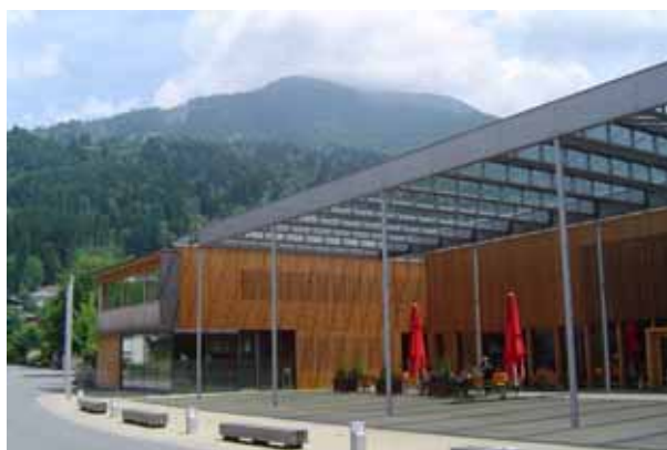
Obr. 7 Pasívna budova, mestský úrad v Ludesch, Rakúsko, strecha s fotovoltaickými panelmi Foto: Vladimír Šimkovic
